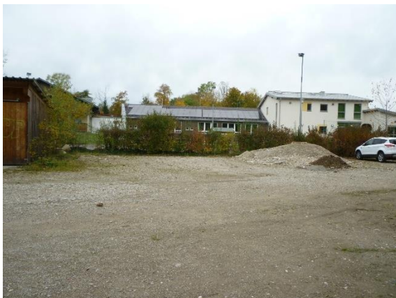
Abb. 3 Planungsgebiet Blick von Osten
